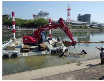
河川 浚渫作業 狀況
