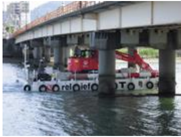
河川橋下 航行 狀況
